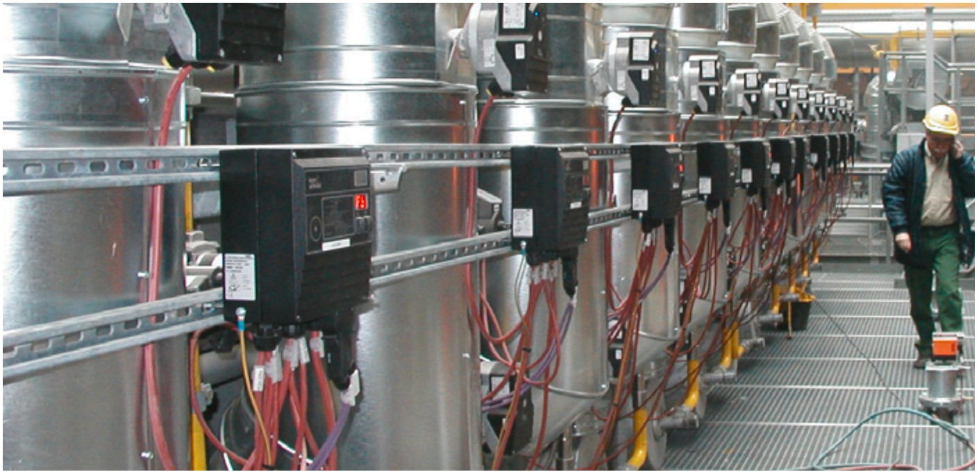
Inbetriebnahme eines Ofens mit BCU und Profibus-DP-Anbindung
